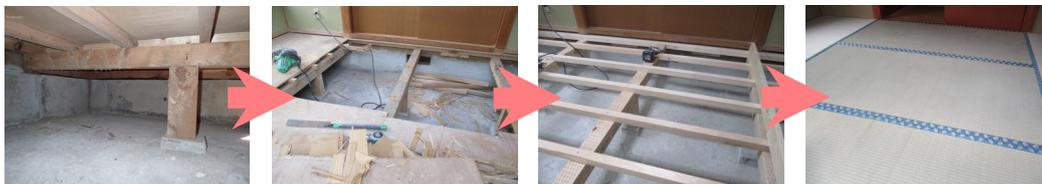
解体前に一部床をはがし点検し予め補修箇所を確認したあと、根太、大引を交換し、薬剤を散布しました。
